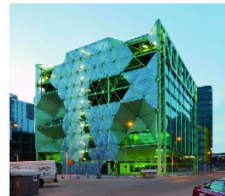
Figura 1.9 El edificio Media-Tic, de Barcelona, está formado por una estructura de hierro y un revestimiento de burbujas de ETFE. Cuando hace calor el material se vuelve opaco evitando el calentamiento del edificio y en consecuencia el uso del aire acondicionado, mientras que cuando hace frío, las burbujas permiten el paso de la luz y, por tanto, no es necesaria la calefacción.
