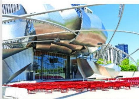
Figura 4.51 Jay Pritzker Pavilion (Millennium Park de Chicago). Este escenario para conciertos al aire libre está hecho de acero galvanizado, el cual mantiene la integridad, funcionalidad y estética de la construcción.
