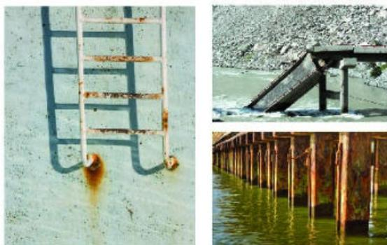
Figura 4.55. Evidencias de corrosión.
