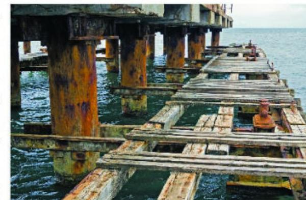
Figura 4.50 La presencia de herrumbre en una estructura es evidencia de que la corrosión de la varilla de acero está muy avanzada y que la seguridad de la estructura, como es el caso de este muelle, es casi nula.
